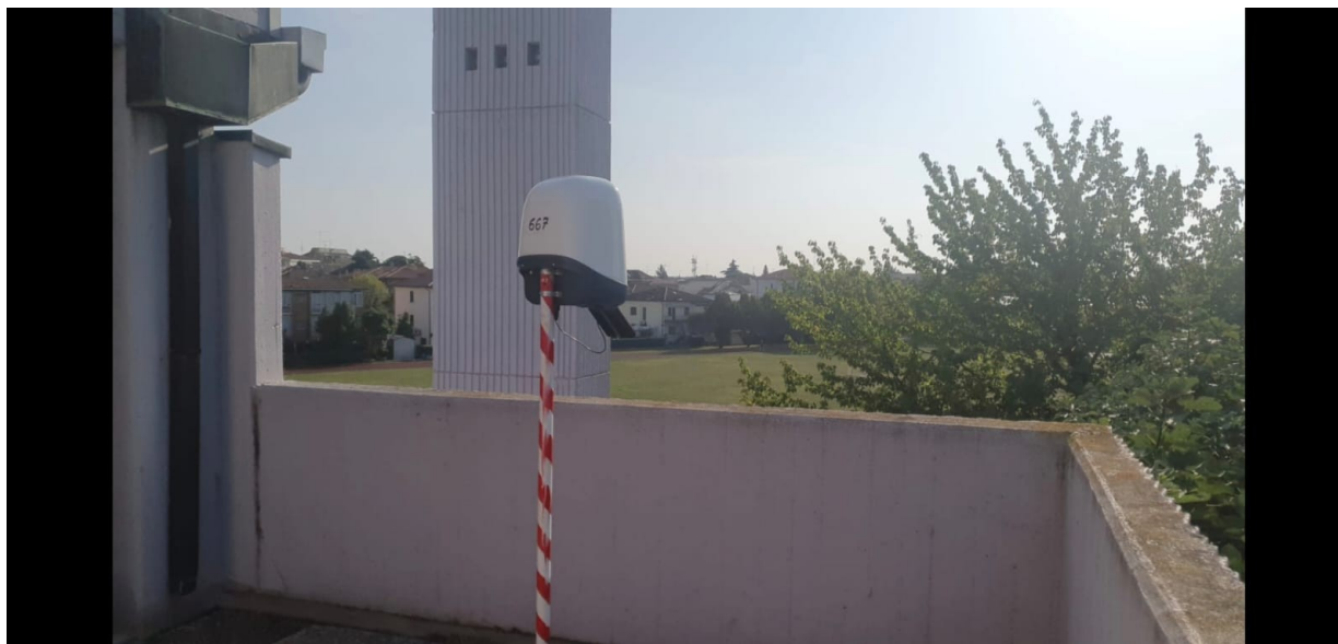
Figura 8 – Postazione ITE “Carlo Matteucci”- Via Turati, 9
