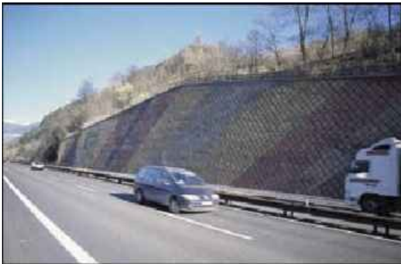
Figura 6 Esempio di biomuro costituito da una base in argilla espansa
