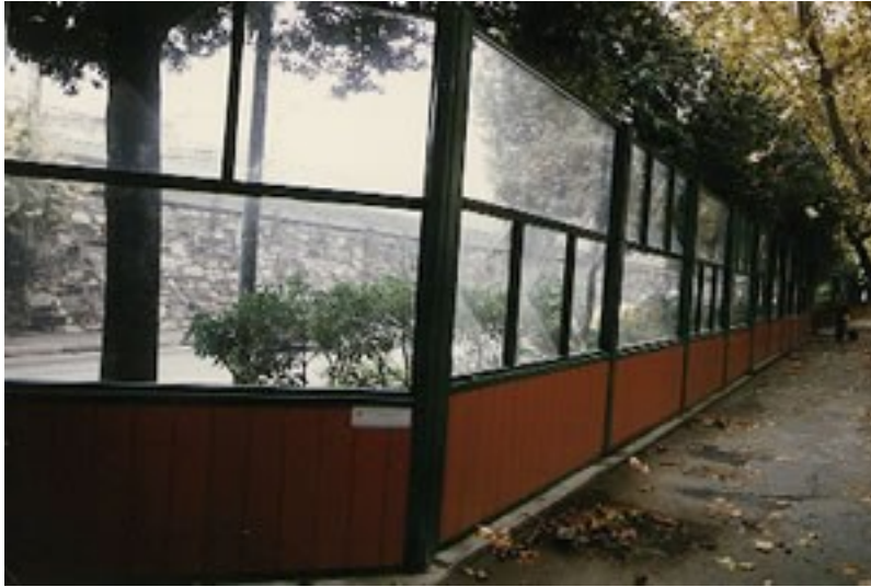
Figura 2 Esempio di barriera fonoassorbente realizzata con pannelli trasparenti
