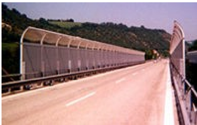
Figura 4 Barriere in lamiera metallica
